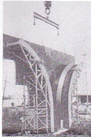
كوفراج معدني لعمود ذي مقطع ثابت شكل « 3 - 85 »
