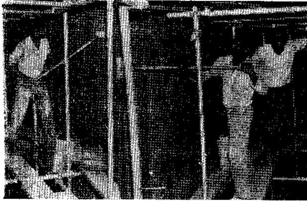
تدهن طبقات الكيما بوكسى بالرولة متعامدة فى الاتجاه الرأسى والأفقى
