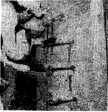
طريقة التخريم لتثبيت الإشاير بالخرسانة القديمة بمادة الايبوكسي
