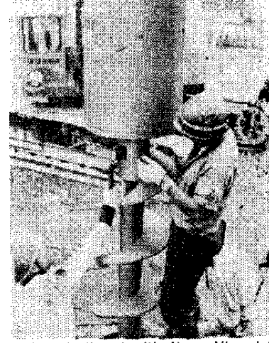
الجهاز العلوي الذي يملأ بالأسمنت والرمل والمادة التي تعطي لدونة وتقوم بضخ المونة في الماسورة التي بداخل البريمة
