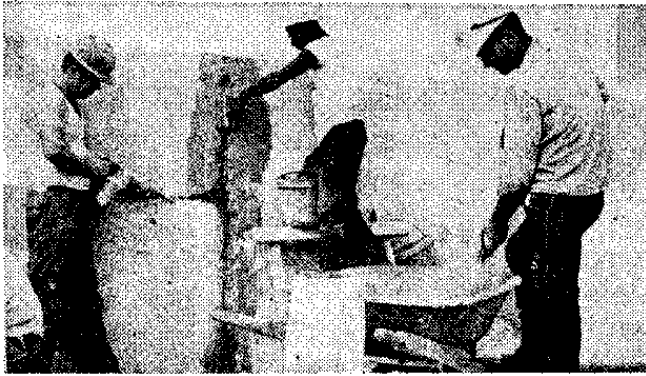
منظر يبين سد الأخرام التى يتدفق منها الماء من المنشأ بمجرد وضع مادة الفاندكس
