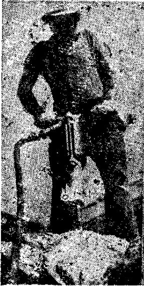
صورة تبين كيف يعمل شاكوش التخريم ضمن الثلاثة شواكيش المستعملة في الضاغط الهوائي
