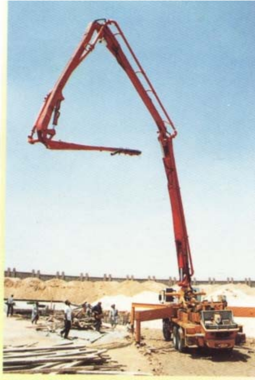
شكل (٤-٤) طلمبة ضخ خرسانة - ٤٢ متر.
