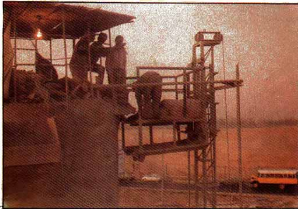
شكل (١٤٨) نقل شكاير الأسمنت من اللورى بواسطة المصعد لتفريغها فى الصوامع
