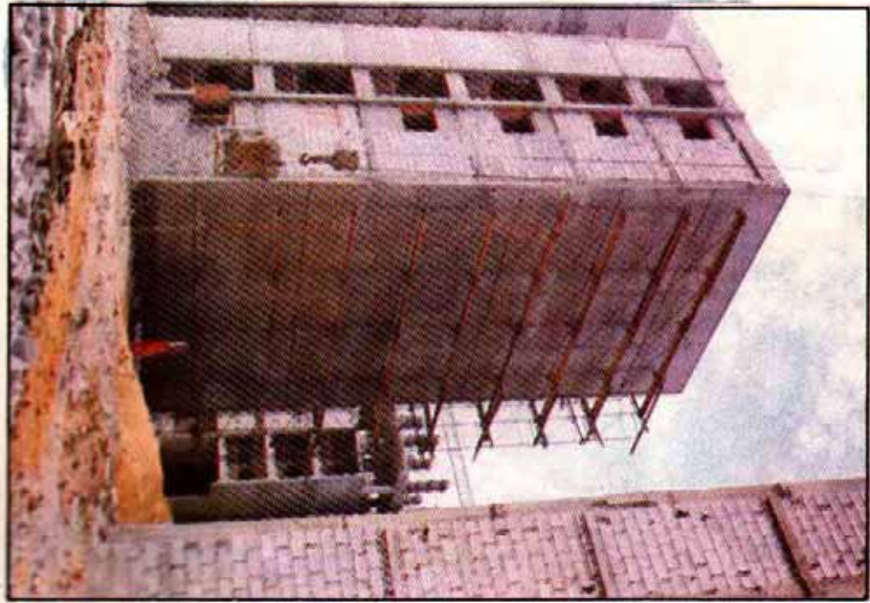
شكل (١٩٠) السقالات المعدنية المستخدمة
