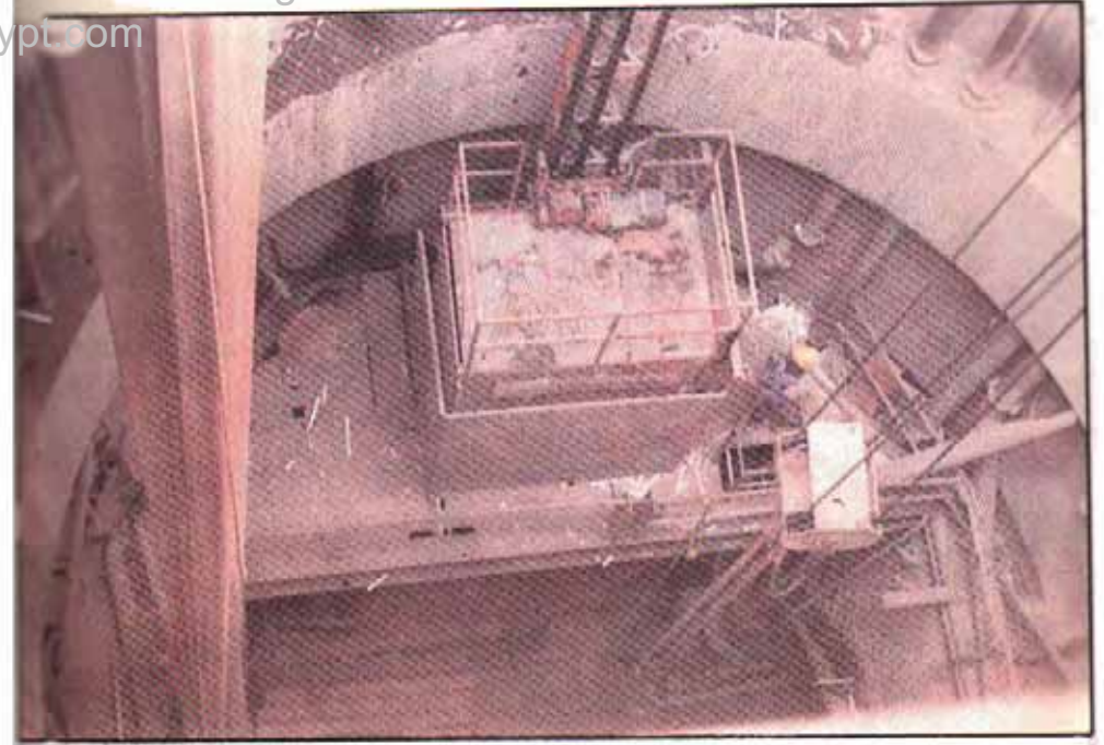
شكل (١٦٣) المصعد لإنزال المواد داخل البناية
